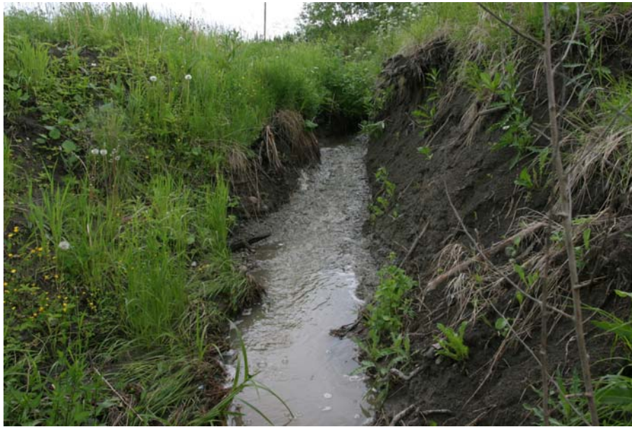
Kuva 8.1. Ojan jyrkkä luiska on epäedullinen kasvupaikka ja sortumiselle altis. Kuva V. Pajunen 18.6.2009.
