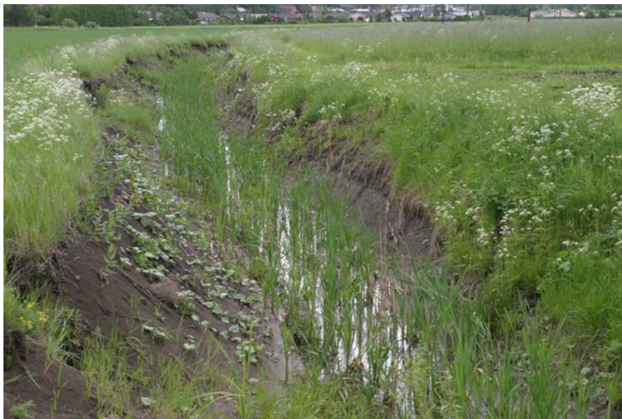
Kuva 8.2. Lähtelänojan herkästi sortuvaa uomaa joudutaan perkaamaan, jotta peltojen kuivatustila pysyy kunnossa. Kuva V. Pajunen 16.6.2009.
