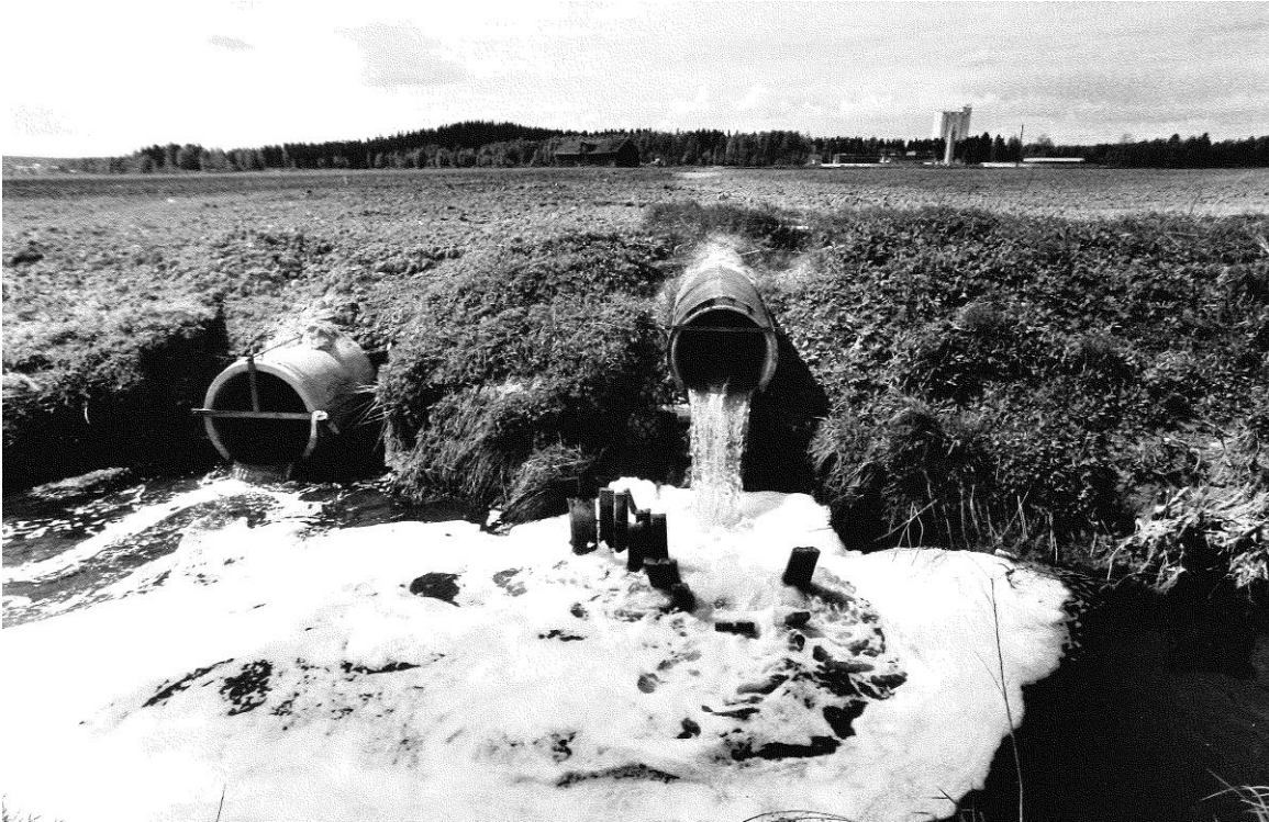
Kuva 2. Riihimäen puhdistamon jätevesien purkupaikka vuonna 1977.
