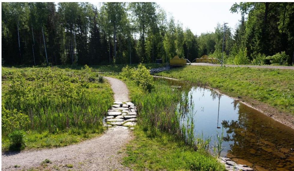
Hulevesirakenteita Helene Schjerfbeckin puistossa Helsingissä.
