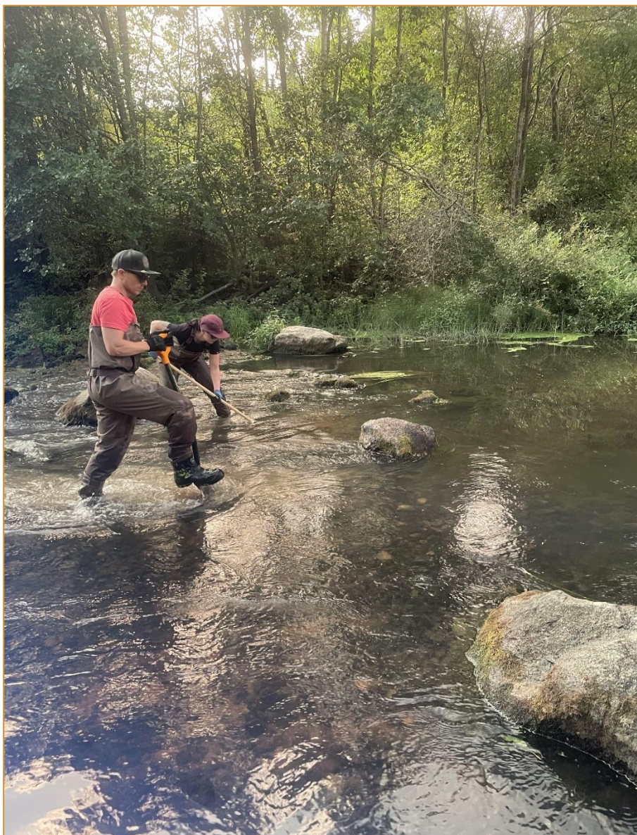
Kuva 2. Soraikkojen huoltoa Haukankoskella kesällä 2022.
