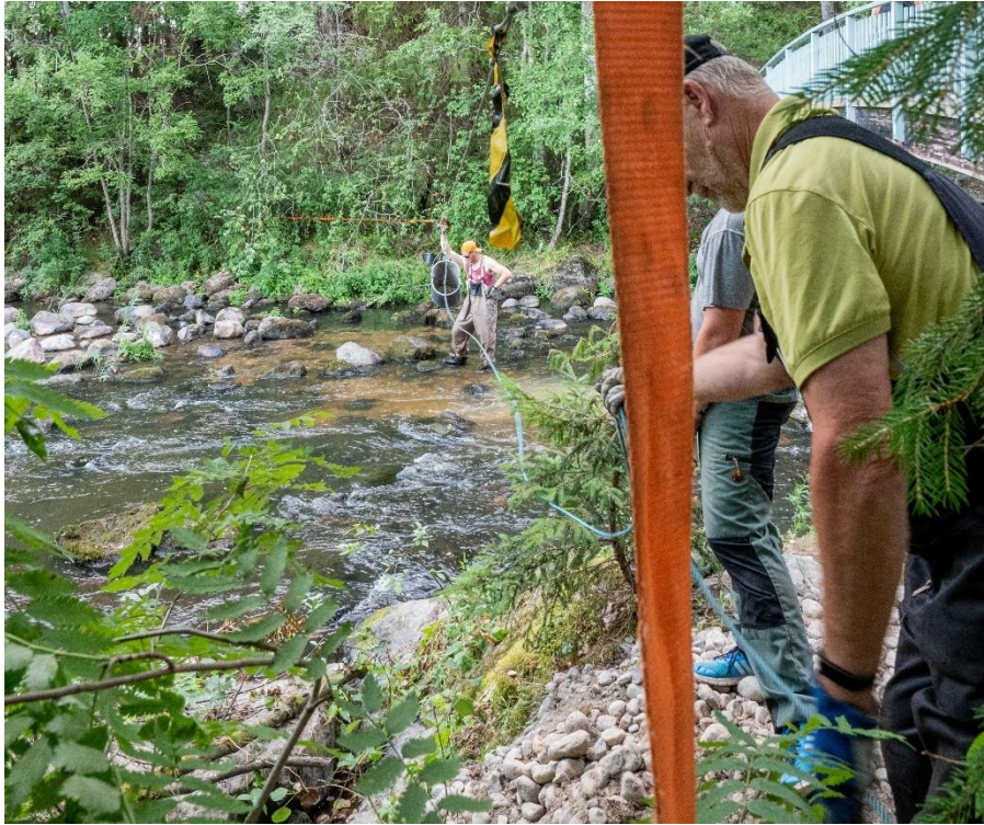
Kuva 4. Vaijeriradan avulla sorasitamista 15.7.2021 järjestetyissä talkoissa.
