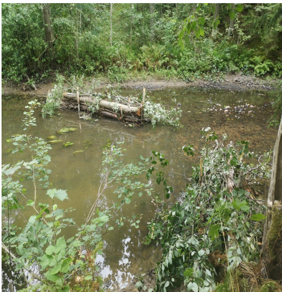
Kuva 2. Korjattu puusuisteet alivirtaama-aikaan. Suisteiden välissä näkyy huollettu soraikko, jolle puusuisteet ohjaavat virtauksen.
