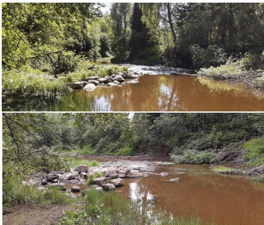
Kuva 3. Vertailukuva Rajakoskelta. Yllä ”ennen”, alla ”lähes jälkeen” rantatörmän syventämisen. Jälkeen kuvassa näkyy rantatörmästä esiin kaivettua luonnosoraa, jota siirrettiin soraikoiksi virtaan
