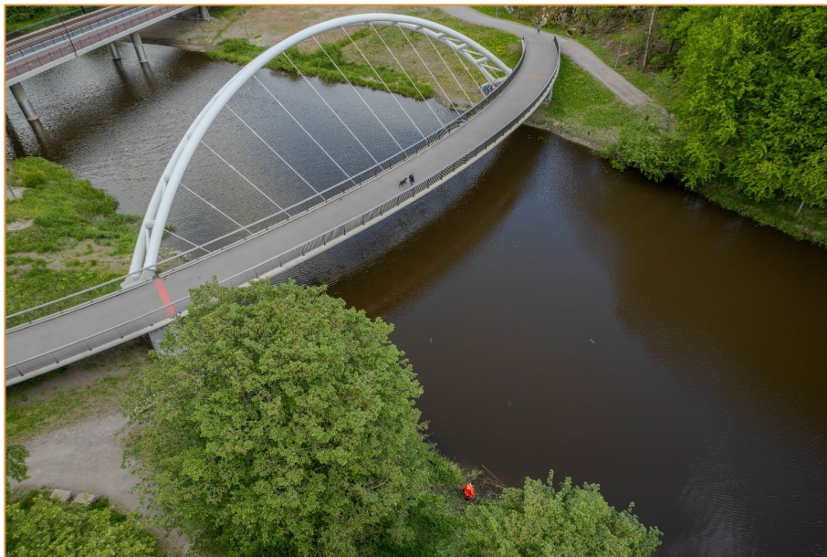
Kuva 2. Kaikuluotainlaitteiston asennuspaikka Oulunkylän Tulvaniitynsillan vieressä.
