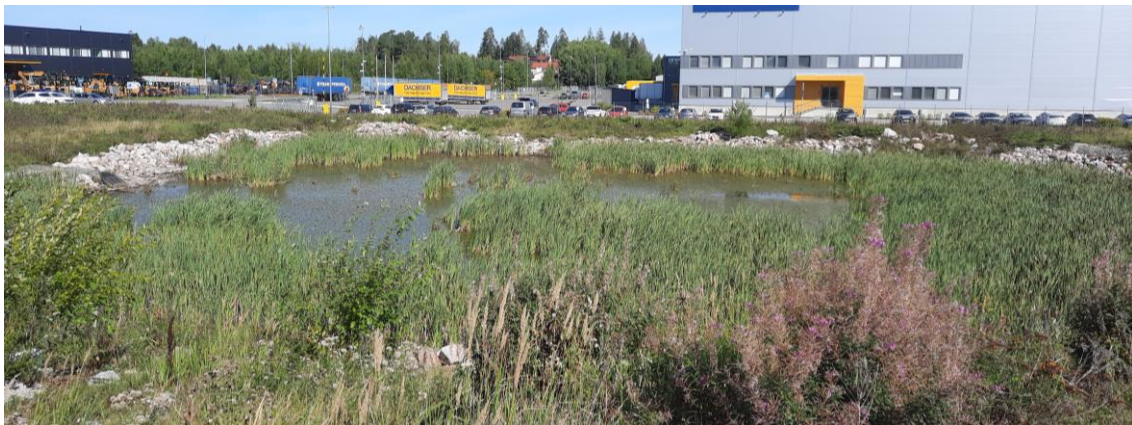
Kuva 22. Osmankäämi on hiljalleen valtaamassa Karhuntassuntien pohjoispuoleisen hulevesien viivytysaltaan (kuva: VHVS 6/2024).
