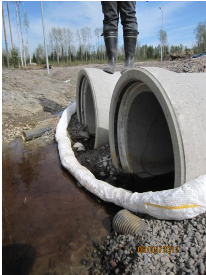
Kuva 9. Itäiseen hulevesialtaaseen johtavien putkien eteen oli asennettu öljynkeräyspuomit toukokuussa 2011 (kuva: Pasi Valkama 2011).
