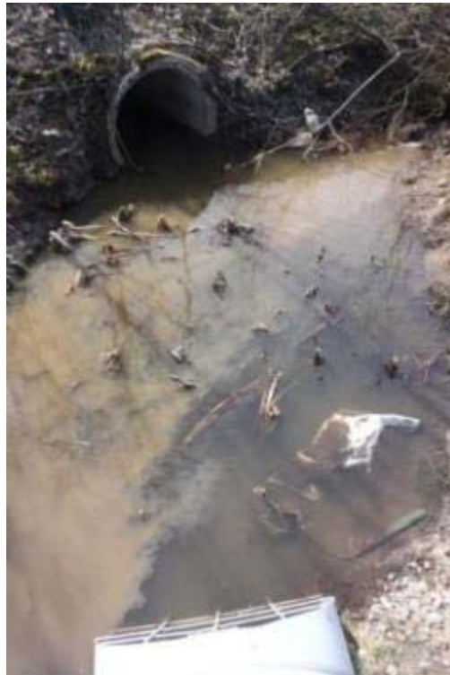
Kuva 15. Hulevesialtaiden välisellä alueella tehdyt kaivaustyöt samensivat Kylmäojan vettä läntisen (allas A) hulevesialtaan alapuolella (kuva: Pasi Valkama 2012).
