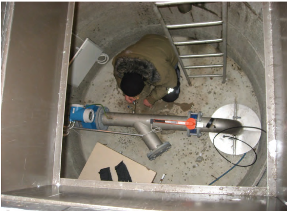
Kuva 11. Nukarin pohjavedenottamon vedenottokaivo, johon asennettiin S::can-mitta-anturi mittaamaan veden laatua tunnin välein jaksolla 14.3.–2.5.2012 (kuva: Anna-Liisa Kivimäki, Vantaanjoen ja Helsingin seudun vesiensuojeluyhdistys ry, 2012).
