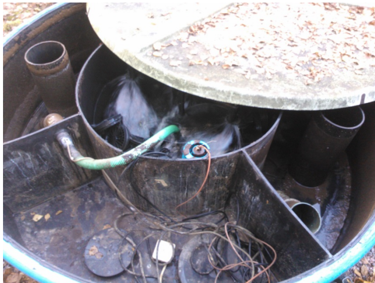
Kuva 13. Laitepuhdistamo, joka oli ollut kyseisen valmistajan pilottikohteena. Laitteessa oli alkuperäisenä enää ulkokuori, ja kiinteistön omistaja oli ollut aktiivisesti mukana laitteen kehityksessä ja huollossa kiinteistön rakentamisesta lähtien.
