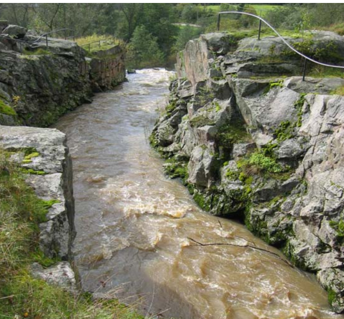
Luhtajoen Kuhakoskella Vantaanjoki virtaa kallioon louhitussa uomassa.
