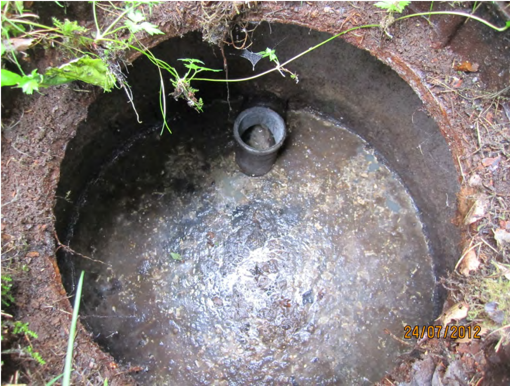
Kuva 1. Kaikille jätevesille tarkoitettu saostussäiliö. Kuva: Teemu Haapala.
