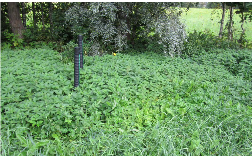
Kuva7. Rehevän kasvuston ympäröimä maaperäkäsittelykenttä. Kuvassa näkyy myös kentän purkupään ilmastusputket. Kuva: Teemu Haapala
