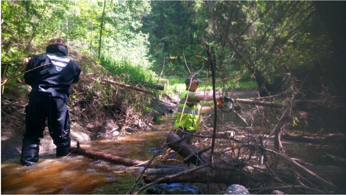
Kuva 5. Kaatuneiden puiden padottaman kohdan aukaisu Keravanjoella. Jokuoman vasempaan laitaan on tehty noin 1,5m leveä melontaväylä.
