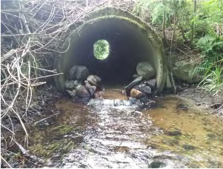
Kuva 7. Selänojantien alittava tierumpu. Kuvan keskeltä, peltilevyn alapuolelta on poistettu pari kiveä, jotta peltilevyn muodostama kynnyks pienenesi.
