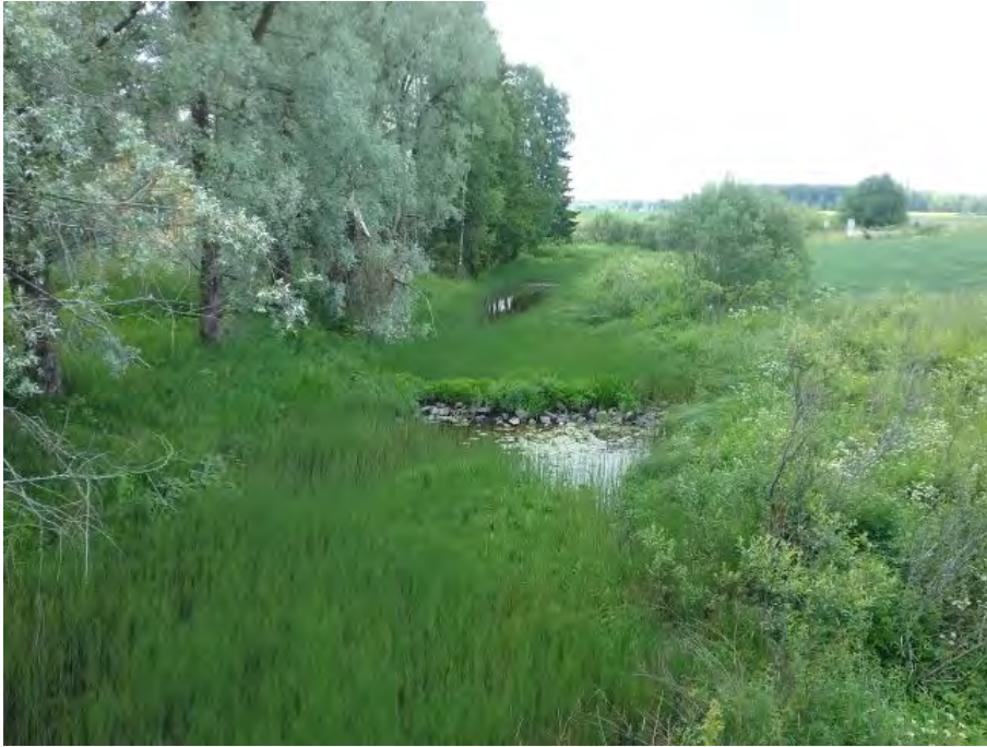
Kuva 64. Ohkolantien yläpuolinen pohjapato.
