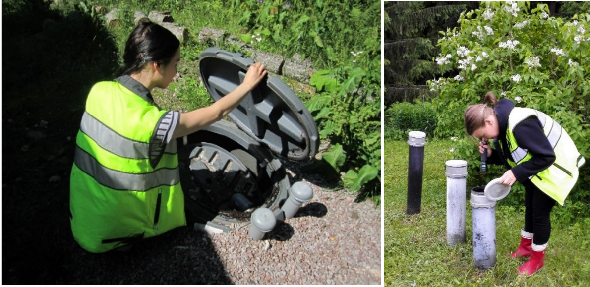
Kuva 1. Jätevesineuvojat kiinteistökäynneillä tutkimassa harmaaavesisuodinta (vasemmalla) ja saostussäiliöitä (oikealla).
