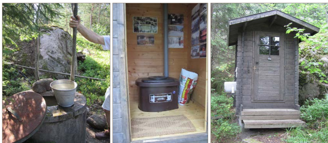
Kuva 3. Vapaa-ajan asunto, jossa vesi kannettiin sisään (vasemmalla) ja käymälä oli vedetön (keskellä ja oikealla), oli tyypillisin tapaus, jossa veden käyttö arvioitiin vähäiseksi (sininen arvio).
