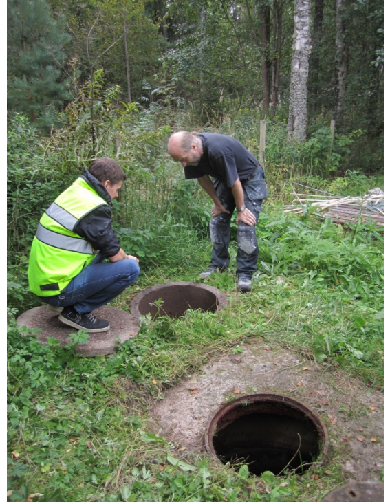
Kuva 2. Hajajätevesineuvoja Teemu Haapala (vasemmalla) kiinteistökäynnillä tutkimassa saostuskaivoja ja kertomassa vesiensuojelusta.
