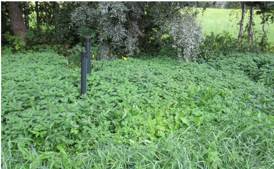
Kuva7. Rehevän kasvuston ympäröimä maaperäkäsittelykenttä. Kuvassa näkyy myös kentän purkupään ilmastusputket. Kuva on neuvontahankkeesta 2012.
