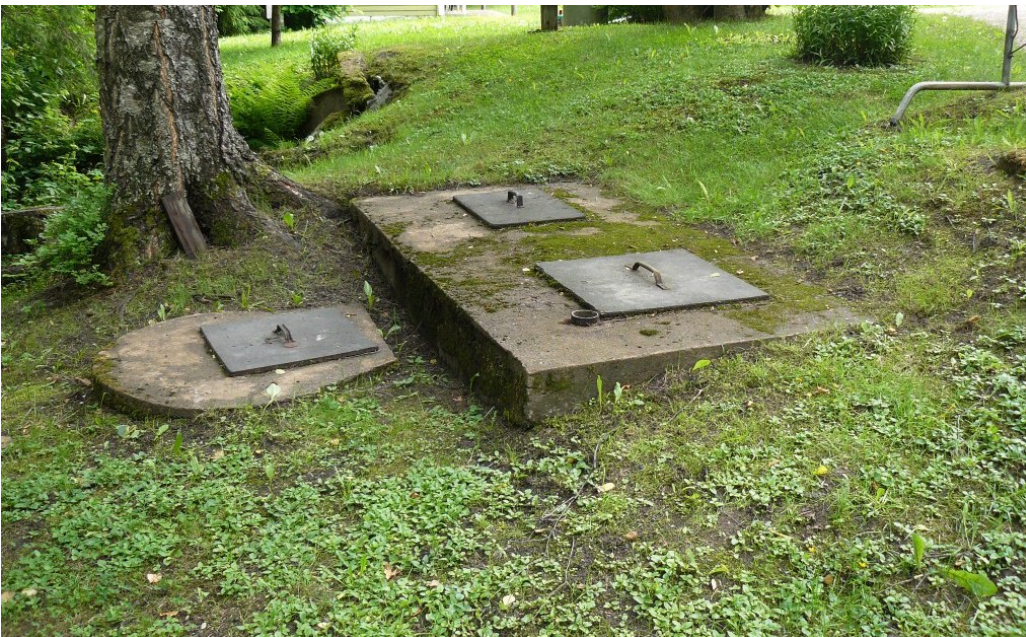
Kuva 5. Tyypillinen näky vanhalla neuvontakiinteistöllä. Saostussäiliöjärjestelmä, johon on rakennettu kolmas saostussäiliö myöhemmin. Kuva: Esra Marvin.
