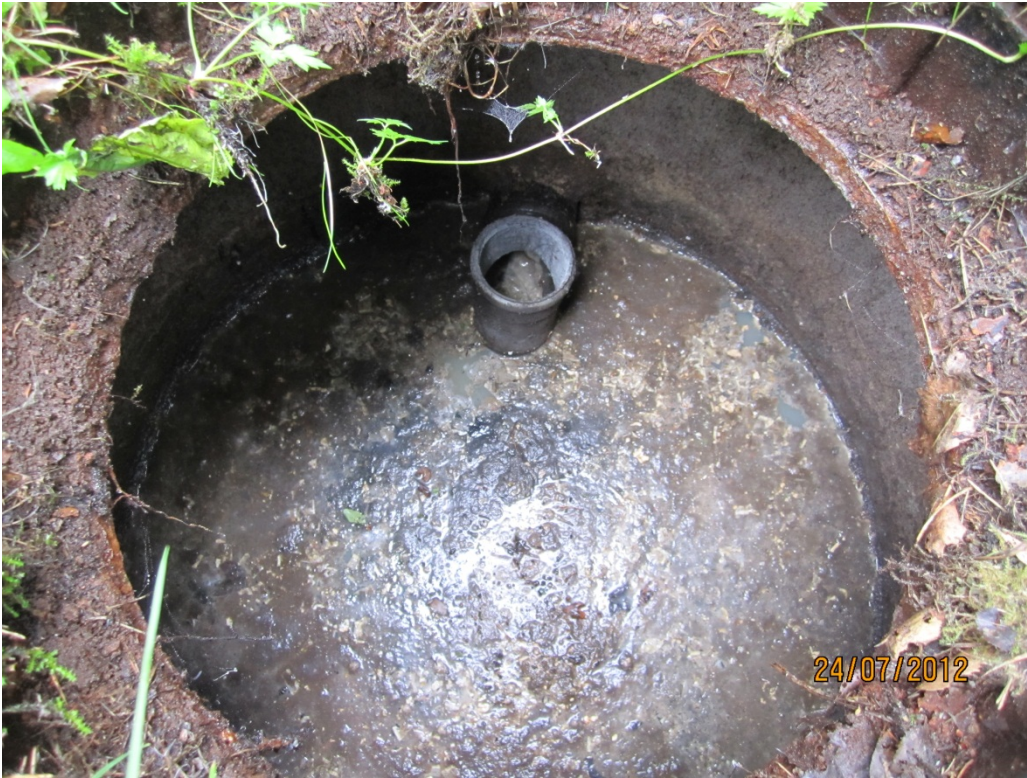
Kuva 1. Kaikille jätevesille tarkoitettu saostussäiliö. Kuva: Teemu Haapala.
