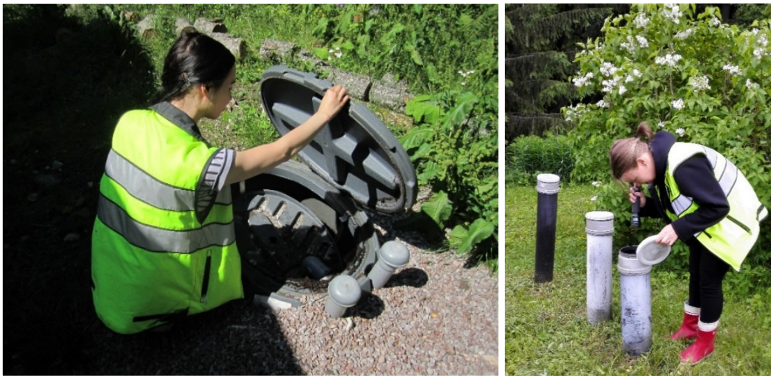
Kuva 1. Jätevesineuvojat kiinteistökäynneillä tutkimassa harmaavesisuodinta (vasemmalla) ja saostussäiliöitä (oikealla).
