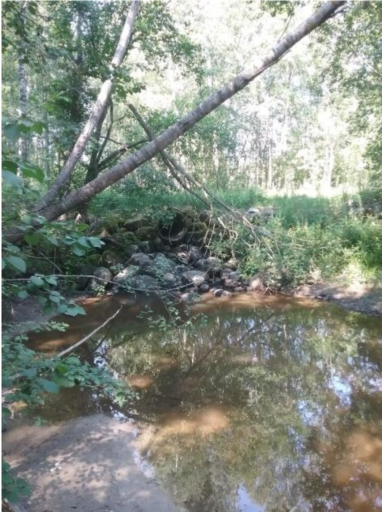
Kuva 47. Vaellusesteenä toimiva tienrumpu alavirrasta kuvattuna.
