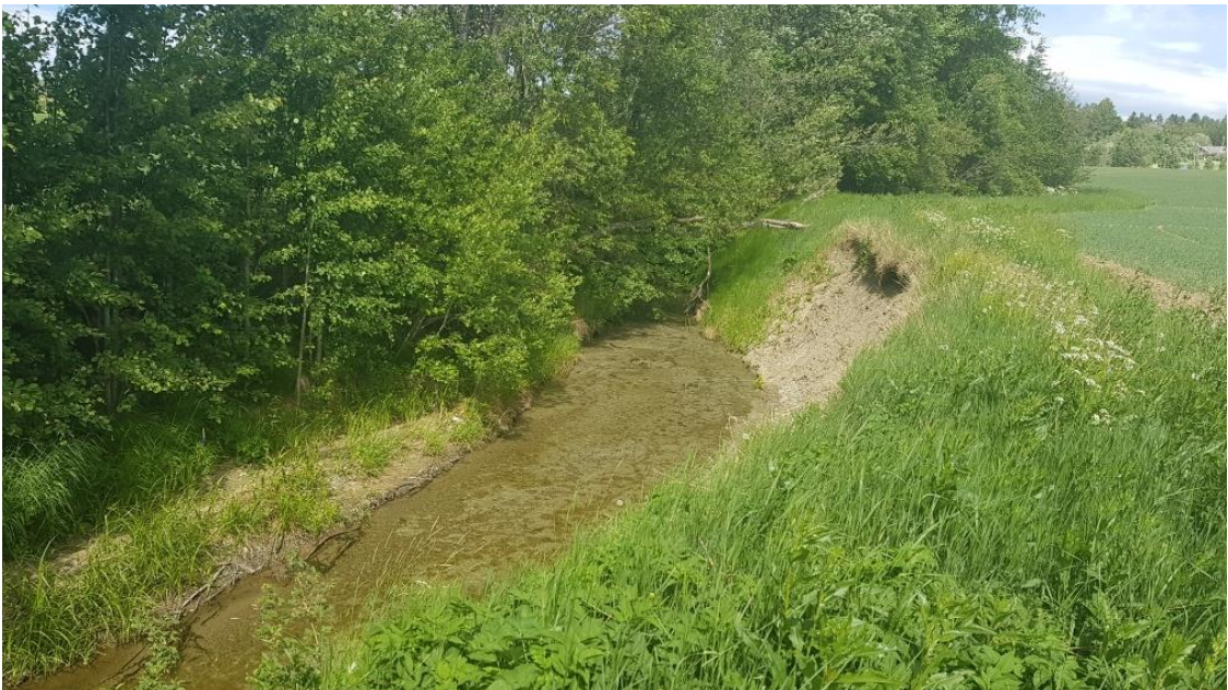
Kuva 6. Nummenpääntien alapuolisen koskialueen alapuolista uomaa (kuva ylävirtaan). Rantapenkka on osin sortunut, ja siitä tulee lisää savea uomaan sateiden ja tulvien aikaan.
