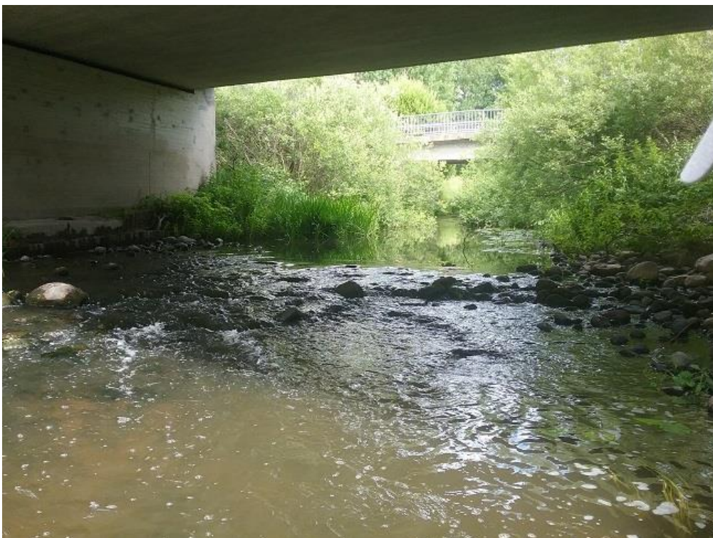
Kuva 26. Shellinkoskea kuvattuna Klaukkalantien alta ylävirran suuntaan. Alueella on vähän kutemiseen soveltuvia alueita ja kohtalaisesti pienpoikasille sopivaa habitaattia.
