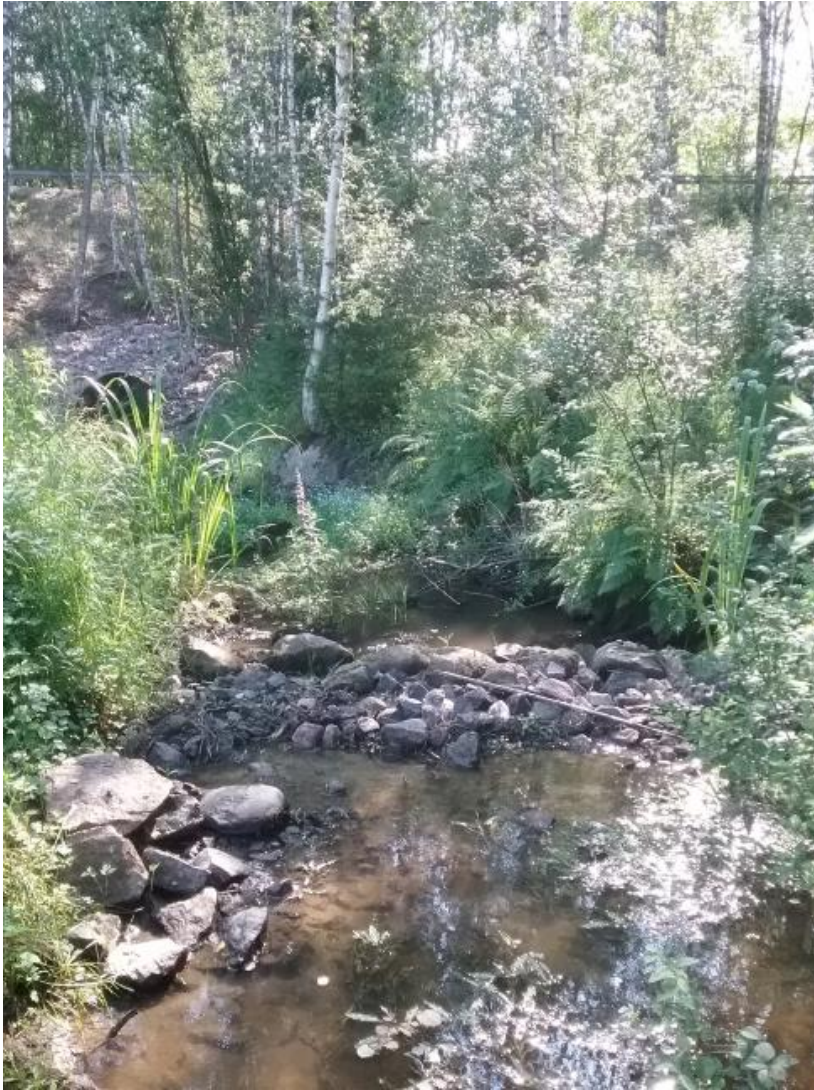
Kuva 32. Raasillanojassa Vihdintieltä ylävirtaan sijaitseva pohjakynnys ylävirrasta kuvattuna.
