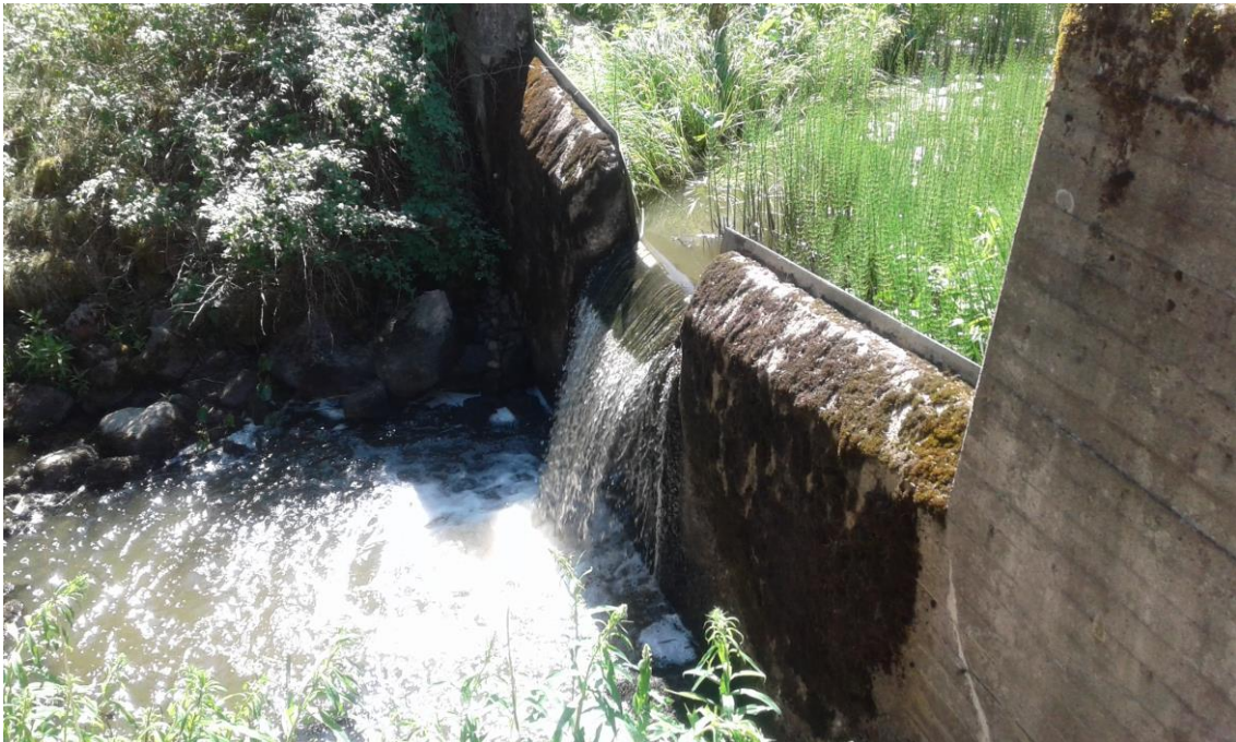
Kuva 39. Härkälänjoen yläosilla sijaitseva säännöstelypato, joka muodostaa täydellisen vaellusesteen.
