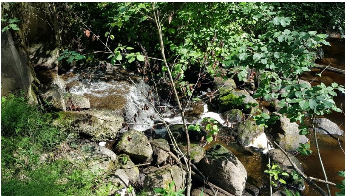
Kuva 45. Vesterkullan koillispuolella sijaitsevan säännöstelypadon alaosa. Kuvassa näkyvä osuus on vain noin vajaa puolet padon aiheuttamasta kokonaispudotuskorkeudesta.
