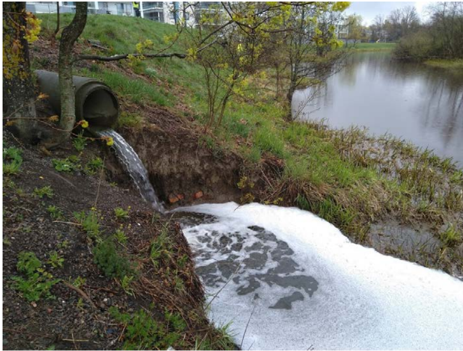
Kuva 9.1. Kaupunkialueella jokien vaahtoamisesta tulee ajoittain kyselyjä. Se on virtavesissä tavallista sateen jälkeen. Kuvassa jokipenkkaa sortanut hulevesirumpu tuo vesiä pientalovaltaiselta asuntoalueelta Keravanjokeen. (kuva: VHVSY/HV)
