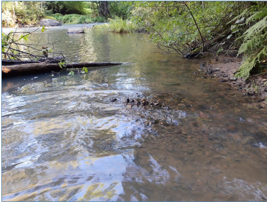
Kuva 85. Solbacka 1 -alueelle rakennettu suiste puhdisti joen pohjaa kiintoaineksesta myös suisteen ja itärannan väliltä.
