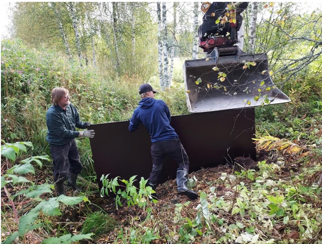
Levy painetaan kaivinkoneen kauhalla penkkaan.
