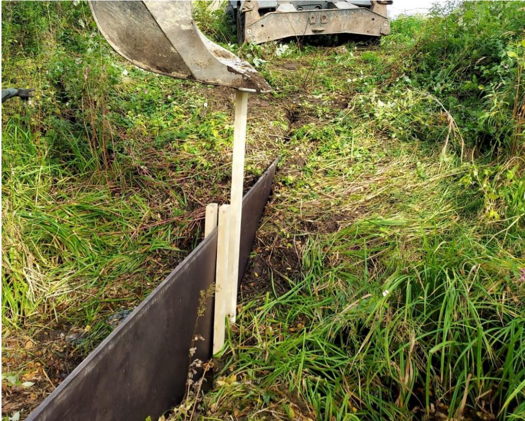
Kaivinkoneen kauhalla painetaan tukipuut levyjen viereen. Tukipuut ruuvataan kiinni levyyn.
