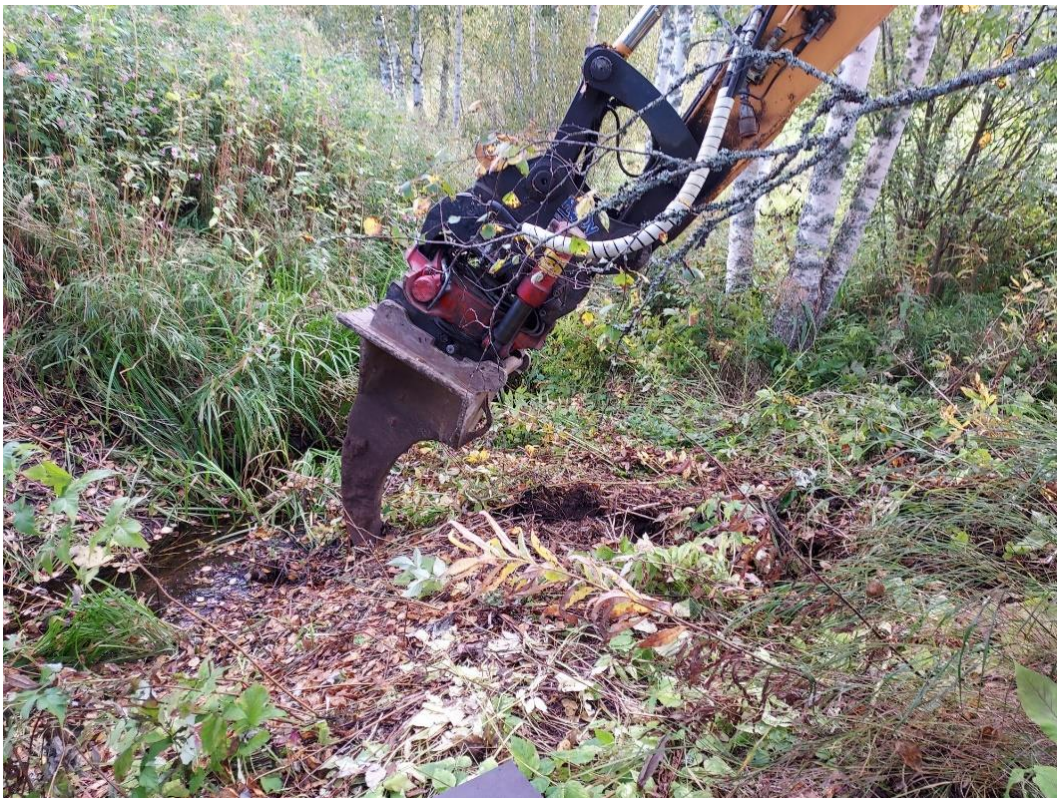
Kaivinkoneen kynnellä vedetään viilto ojan penkkaan vanerilevyä varten.
