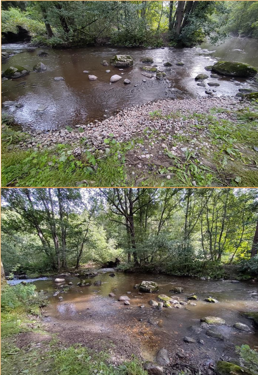
Kuva 4. Koneellisesta kunnostuksesta rannalle jäänyt kutasora (yllä). Kivet siirrettynä veteen (alla).
