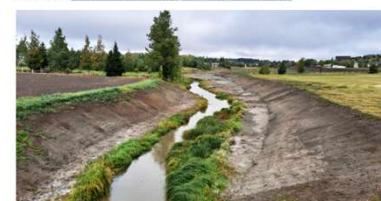
Kuva 2. Esimerkki kakitasuomasta rakentamisen jälkeen. Huom! Alivesiuomaa ei ole perattu ollenkaan ja kasvillisuutta on jätetty koskemattomaksi reunoille, josta se pääsee nopeasti levittymään kaivettuihin alueille. Ei ole tehty kivipeitteitä, vaan uoma saa jäädä luontaiseen tilaan savikkoumaksi. Lohalle penkereelle kasvillisuus levittäytyy nopeasti. Kuvalähde: Luontopohjaiset vesienhallinnan ratkaisut - Valonla
