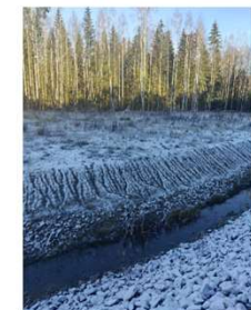
Kuva 14. Uoman yrkässä penkassa näkyy sadeden eroosion aikaansaamia kouruja. Tämän kaltaisista ratkaisuista syntyy täysin turhaa kuormitusta. Kasvipeite on systemaattista kivemistä parempi ratkaisu vesienohjauksen kannalta. Kuva: Jose Ensio
