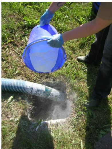
Kuva 2. Saostus- ja umpisäiliölietteiden kalkkistabilointi voidaan suorittaa joko yksittäisessä kaivossa tai yhteiskäsittelypisteessä (valokuvat Mari Ilvonen)
