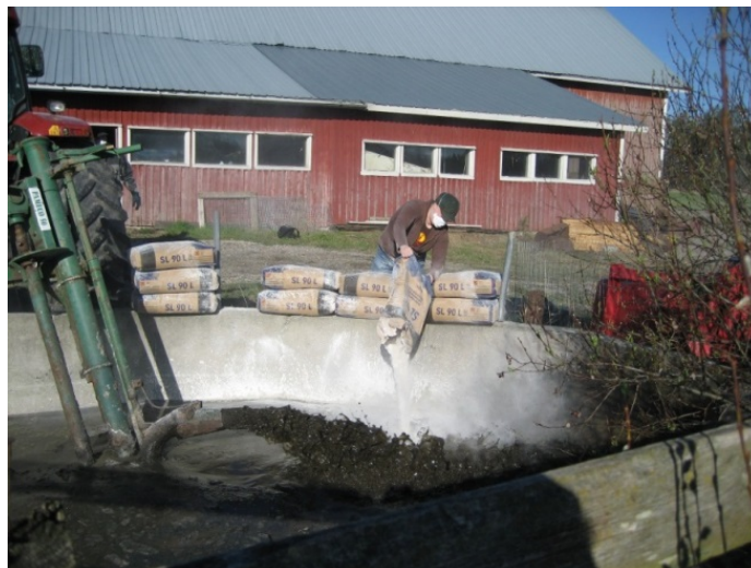
Kuva 2. Saostus- ja umpisäiliölietteiden kalkkistabilointi voidaan suorittaa joko yksittäisessä kaivossa tai yhteiskäsittelypisteessä (valokuvat Mari Ilvonen)
