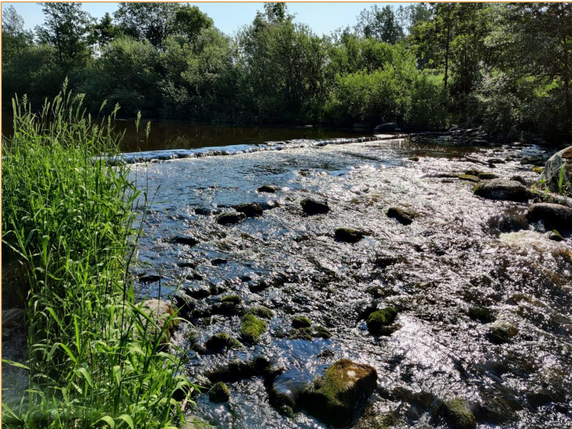
Kuva 16. Hanabölenkosken niskalla sijaitsee betonista valettu pohjakynnys, jonka välittömässä ympäristössä ei voi tehdä kunnostustoimia.
