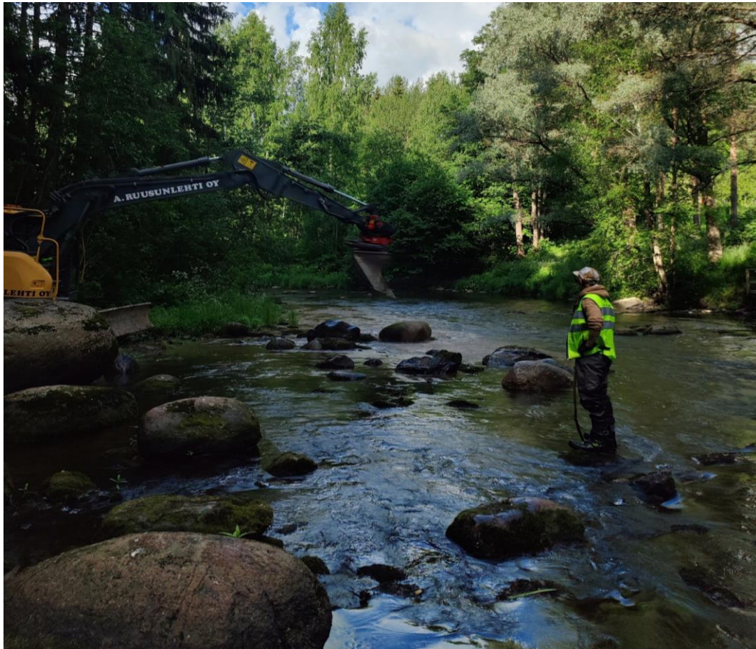
Kuva 2. Soraikon paikan valmistelua kosken keskivaiheilla. Kosken itäranta (kuvassa vasen) oli huomattavan kivikkoisen ja siitä pystyttiin hyödyntämään monen kokoista kiviainesta esimerkiksi poikaskivikkoina. Kiviainesta siirtämällä matalan veden virtausta saatiin ohjattua laajemmalla alueelle, jolloin poikashabitaattien määrä kasvoi.
