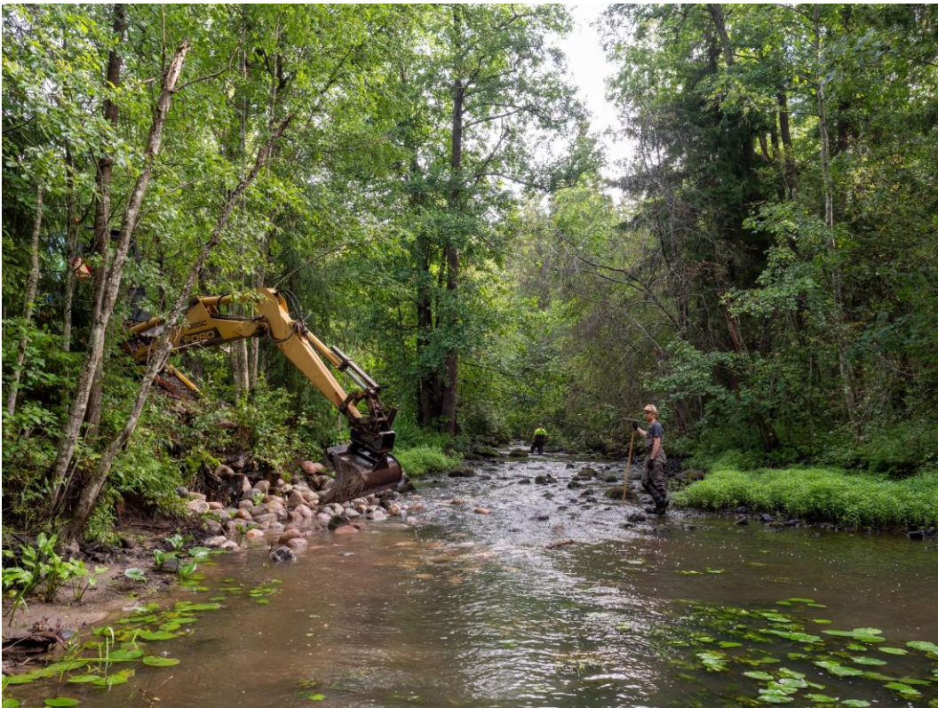
Kuva 9. Kuvassa Solbackan alaosalle siirretään poikaskiveä, joilla tehtiin pieni pohjakynnys, joka jatkoi kosken pituutta, sekä vesitti kuvan oikean reunan kasvien alla olleen luonnonsoraikon.
