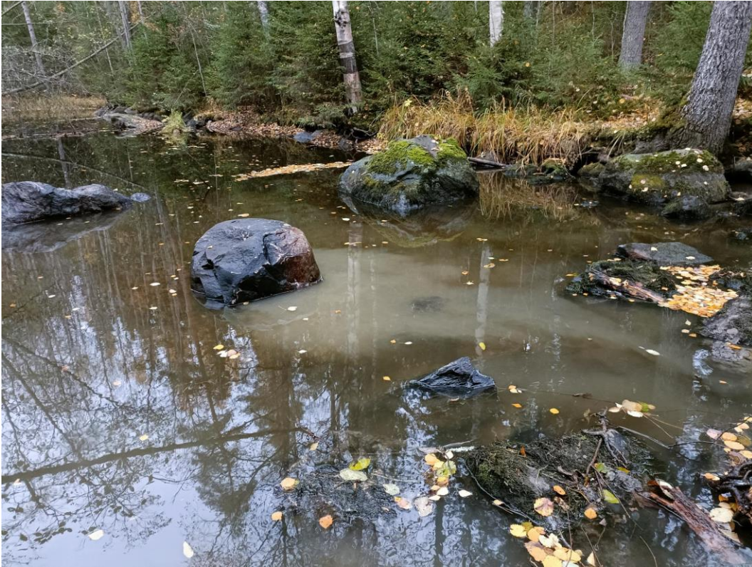
Kuva 12. Kosken niskaa muokattiin siirtämällä kiviainesta ylävirtaan ja toisaalta soraistamalla. Soraikon etureuna on kuvan vasemmassa reunassa sijaitsevan kiven alla. Soraikko jatkuu kuvan oikean reunan kivikkoon asti.
