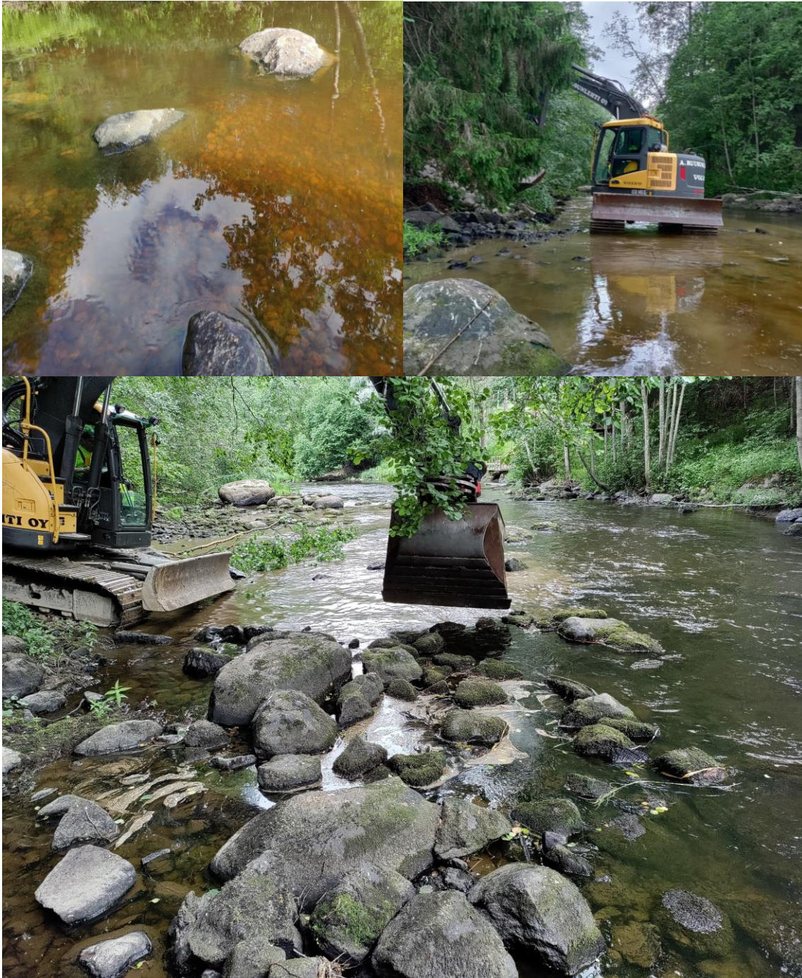
Kuva 1. Ylävasen: Kiskosken niskasoraikkoa. Yläoikea: Kiskon vesi oli paikoittain hyvin matalalla, kuten kaivinkoneen telasta näkee. Alakuva: Koskessa oli runsaasti kivikoita, joita ”avaamalla” pystyttiin luomaan runsaasti uutta pienpoikashabitaattia.
