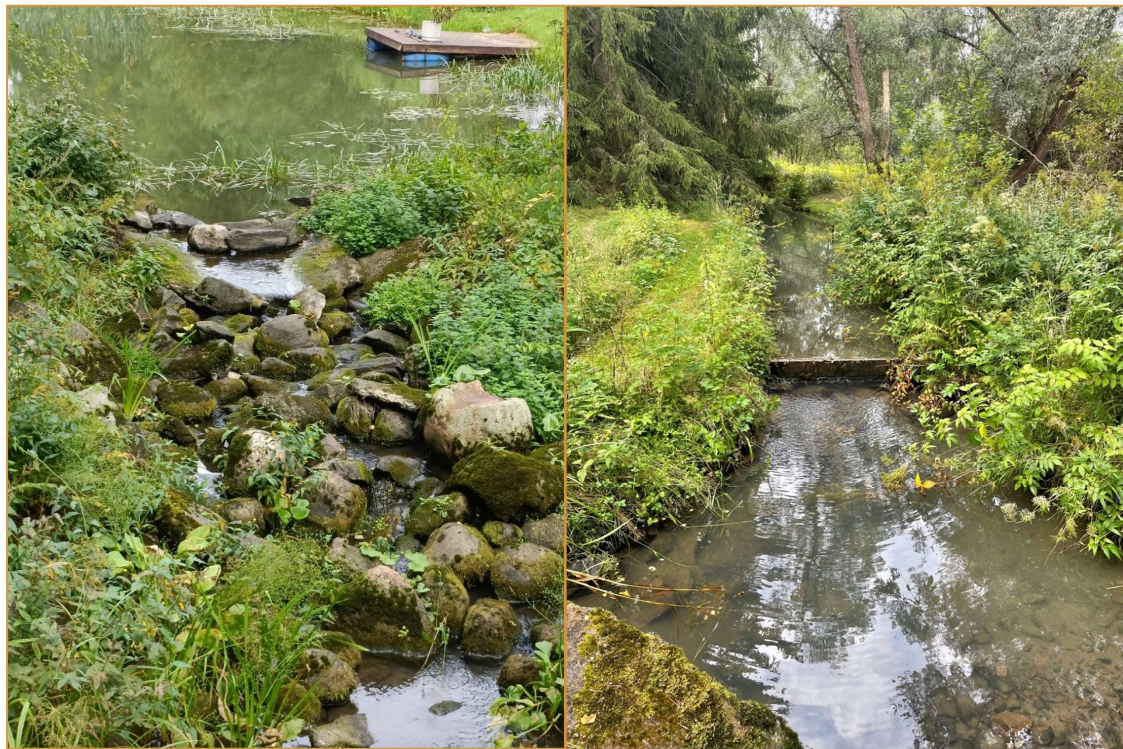
Kuva 12. Vasen: Jusliininojan lammen alapään pohjapato on pienimuotoinen virtapaikka, mutta toisaalta vähävetiseen aikaan vaelluseste. Oikea: Jusliininojan lammen ylävirtaan uomasta löytyy erilaisia padottavia rakenteita.
