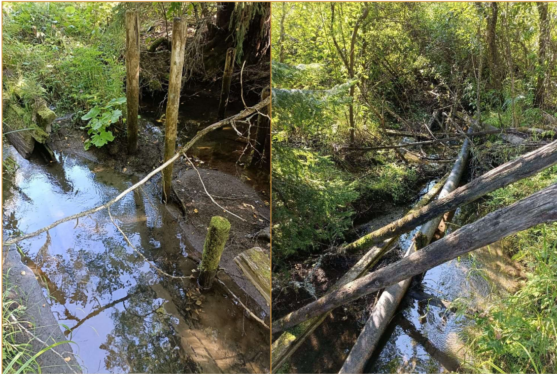
Kuva 2. Vasen: Patorakenteita kylmänojan tiestä ylävirtaan. Oikea: Patorakenteita ylävirrasta alavirtaan katsottuna, rakenteisiin kuuluu muun muassa järeää putkistoa.
