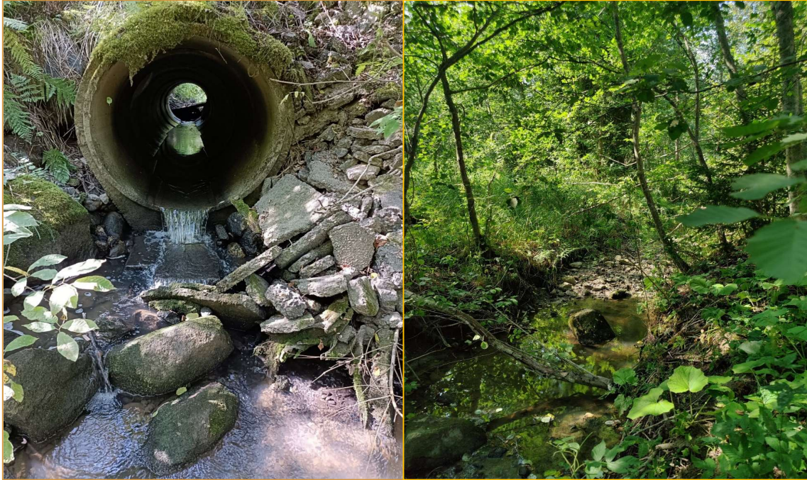
Kuva 5. Vasen: Matinojan alaosalla sijaitseva kalojen puroon nousun estävä tierumpu. Oikea: Papinojan virtapaikka ylävirtaan kuvattuna.
