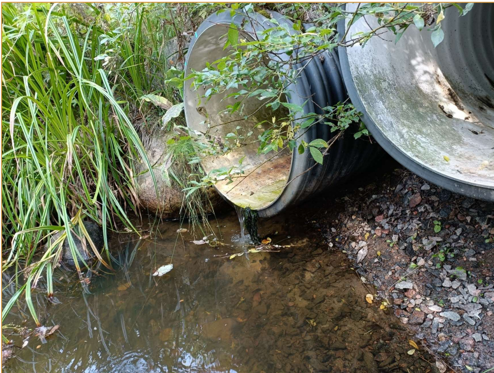
Kuva 22. Virtaus Hakalanojassa oli hyvin heikko. Matalatkin tierummut toimivat vaellusesteinä ja puro oli paikoitellen lähes kuivunut.
