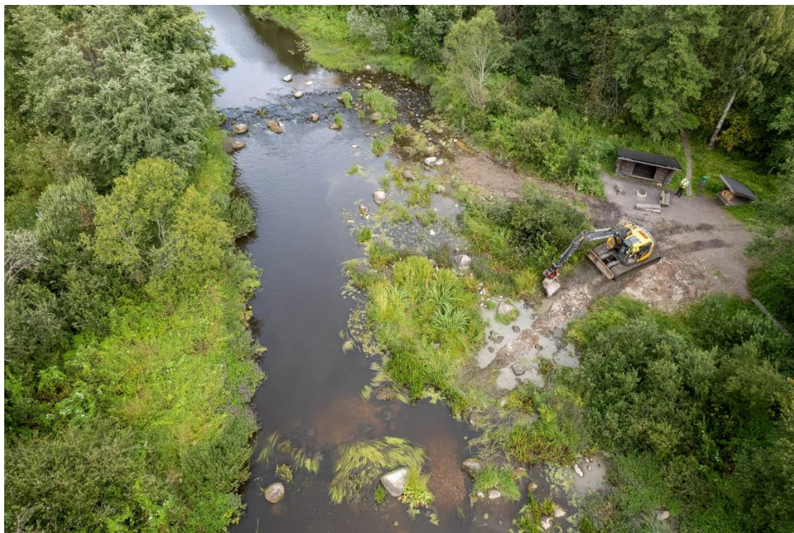
Kuva 6. Vuohenpääkosken niskakynnys taustalla ja etualalla alemmat kunnostussoraikot. Uudet soraikot erottuvat vaaleina.
