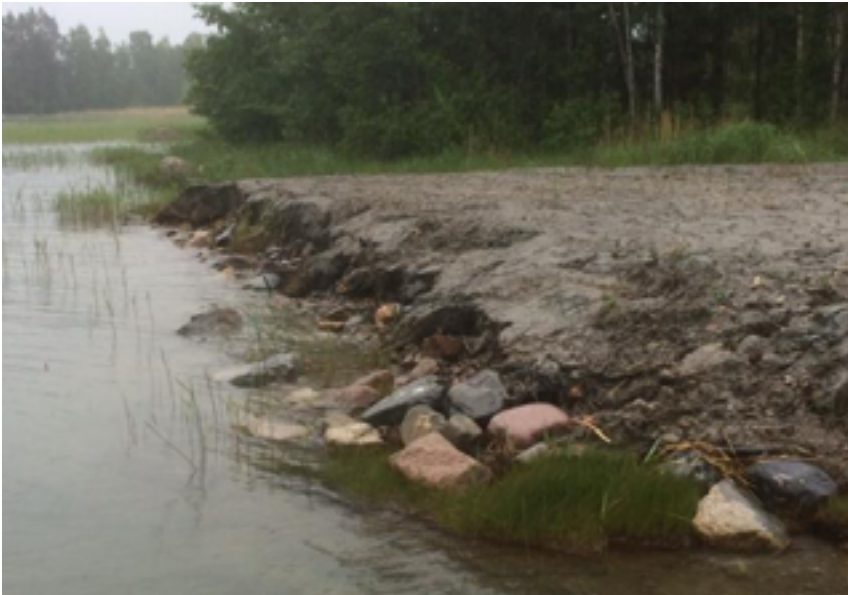
Kiviverhoilulla massat voidaan maisemoida ja varmistaa samalla niiden paikoillaan pysyminen. Kuva: Vesa Vaihi, Naantalin ranta- ja maanrakennus Oy.
