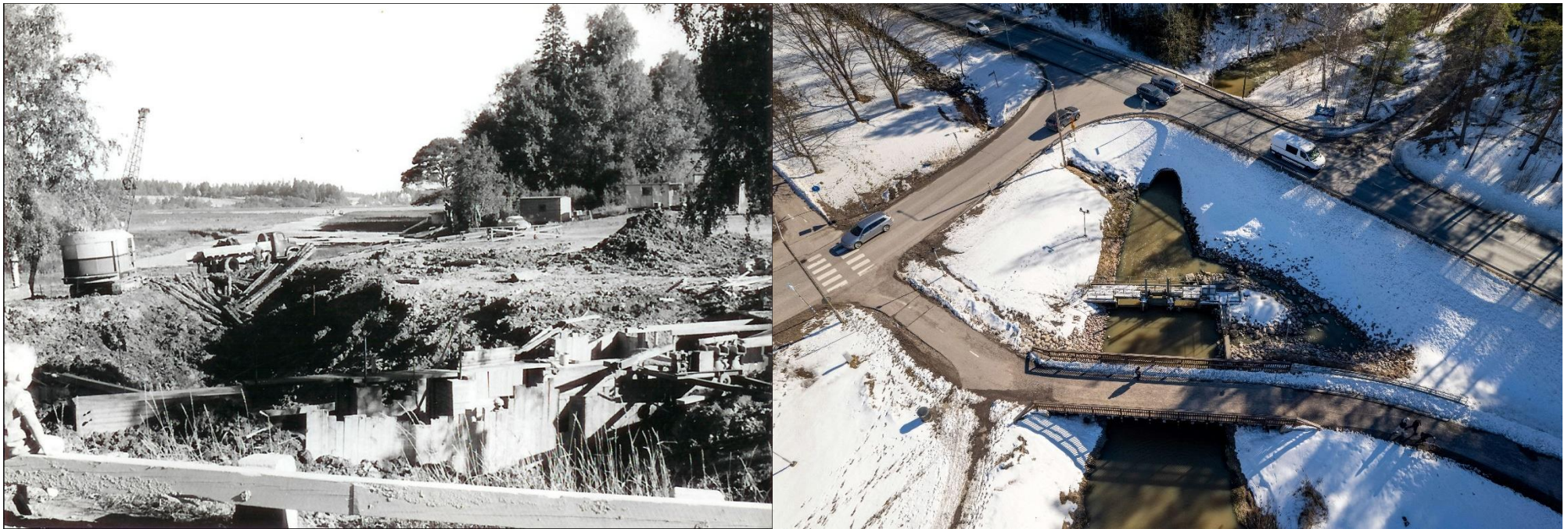
Kuva 4. Tuusulanjärven luusuaan rakennettu säännöstelypato rakennusvaiheessa vuonna 1958 (vas.) ja säännöstelypato kalateineen maaliskuussa vuonna 2023 (oik.). Kuvat: Koskensäällä padon rakennus 1958, kuvaaja Vesa Savimaa; Tuusulanjärven pato ja kalatie, VHVSY kuva-arkisto.
