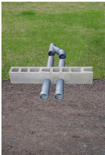
Kuva 18. Uusiin haja-asutusalueille rakennettaviin kiinteistöihin pesu- ja käymälävesien erillisviemäroinnin ulottaminen talon ulkopuolelle (A) tukee asetuksen teknologianeutraaliuden periaatetta.
