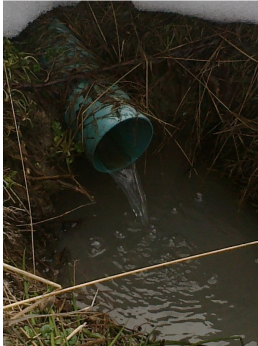
Kuva 16. Kiinteistön M2 maasuodattamosta purkautui keväällä 2012 vettä noin 8 l/min (=11,5 m 3 /vrk).
