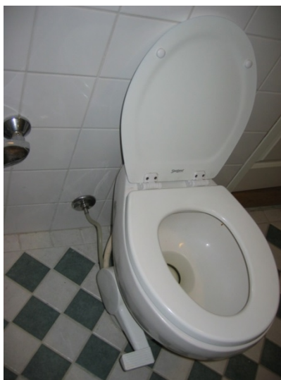
Kuva 17. Vähän vettä käyttävä WC-istuin käyttää vettä vain noin 0,5 litraa/huuhtelu. Käytön rajoitteena on viemäri- ja putkijärjestelmän pituus, alle 10 metriä.
