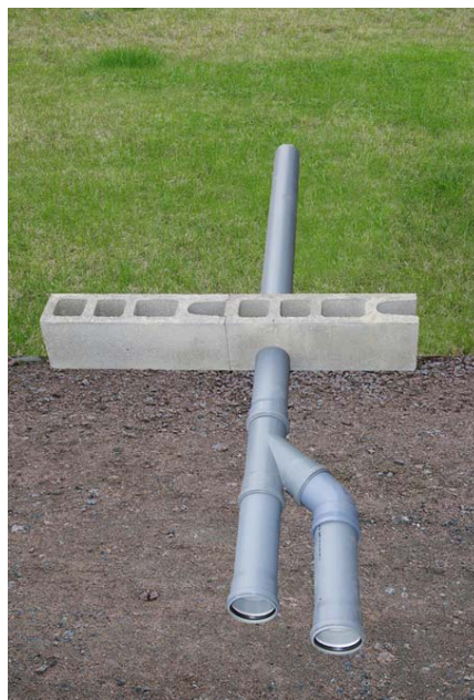
Kuva 18. Uusiin haja-asutusalueille rakennettaviin kiinteistöihin pesu- ja käymälävesien erillisviemäroinnin ulottaminen talon ulkopuolelle (A) tukee asetuksen teknologianeutraaliuden periaatetta.
