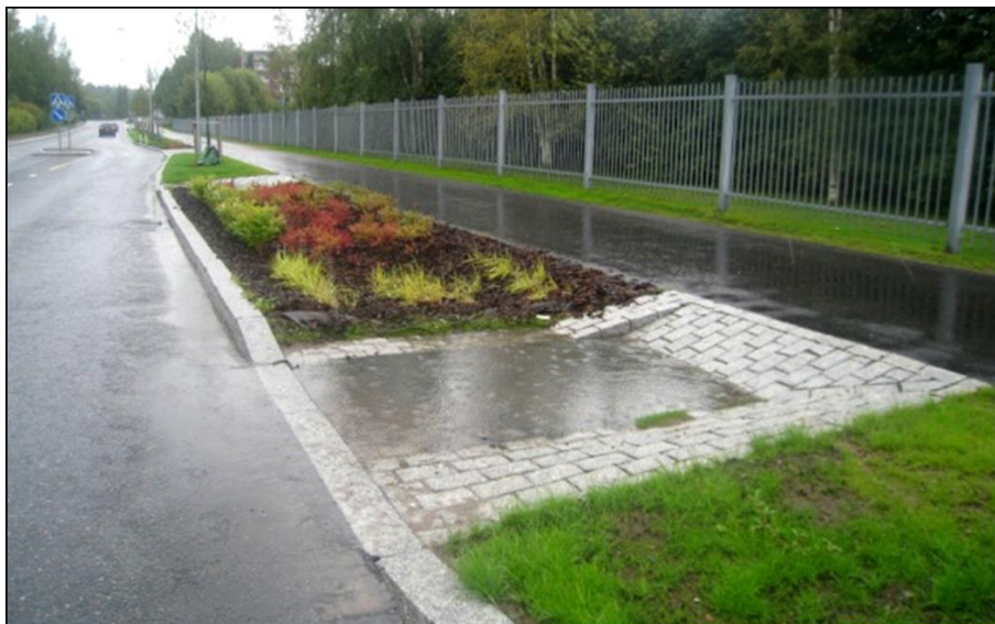
Kuva 4.2 Yksi Meiramitien biosuodatusalueista. Kivetys kerää asfaltoidun alueen vedet ja johtaa ne kasvitetulle alueelle suotautumaan. (kuva Elina Lehikoinen)
