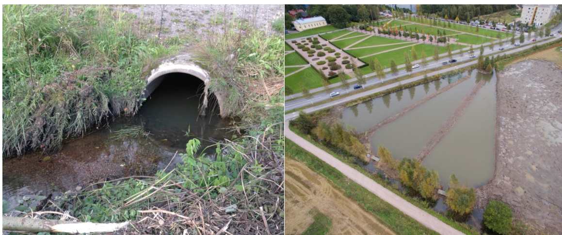
Kuva 4.1 Viikin alueelta hulevedet purkautuvat pelto-ojaan, johon rakennettiin kesällä 2015 Keidas - urban oases -hankkeessa hulevesien viivytyksratkaisu. Kuvan hulevesirumpu (Viikin näytepaikka) sijaitsee oikean puoleisen kuvan oikeassa ylänurkassa. (Kuvat: Heli Vahtera (vasen), Antti Nykänen (oikea)).
