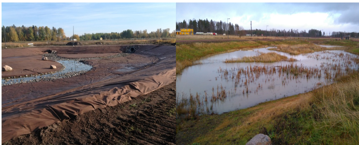
Kuva 4.3 Lepola 2 kosteikon allas 2. Vasemman puoleisessa kuvassa (lokakuussa 2014) näkyy vasemmassa yläreunassa kosteikkoon vesiä tuova hulevesirumpu sekä oikealla altaasta 1 tuleva yhdysputki. Oikeanpuoleisessa kuvassa allas on kuvattu joulukuussa 2015 (kuvat Heli Vahtera).
