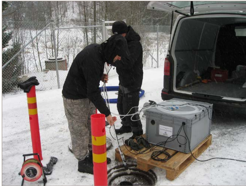
Kuva 12. Anturimittausaseman asennusta Hyvinkäänkylässä maaliskuussa 2017 (kuva A.-L.Kivimäki, VHVSY).
