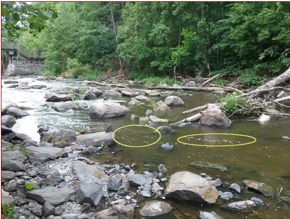
Kuva 65. Siltojen väli hieman myllysilän jälkeen kuvattuna Alueella on monipuolista habitaattia, joka tarjoaa runsaasti suoja- ja ruokailupaikkoja eri-ikäisille lohikaloille. Alueella on useita pienimuotoisia soraistettavia alueita. Ennen soraistamista tulee kuitenkin pohjaa avata ja siirtää isompia kiviä sivuun, jotta lisättävää soraa ei turhaan kulu kivien välisten kolojen täyttämiseen. Puumateriaalia ei tule poistaa uomasta. Soraistettavat alueet ovat pääsääntöisesti pieniä, noin 1,5–2,5 neliömetrin suuruisia.
