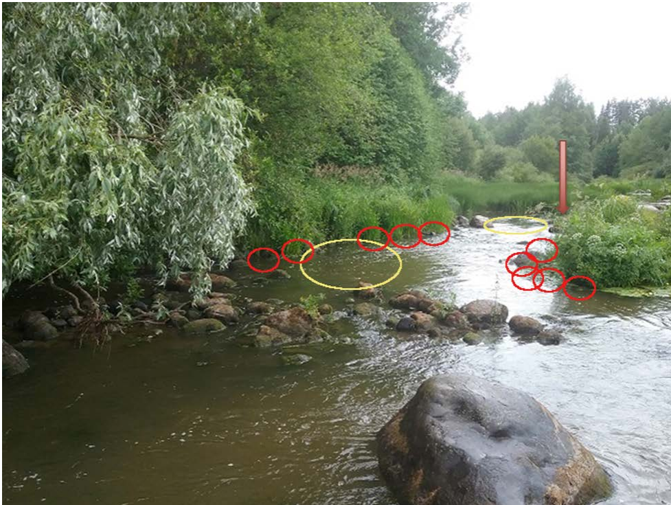
Kuva 30. Heinäsaarekkeen (saarekkeen etureuna merkitty nuolella kuten aiemmissa kuvissa) ja rannan välissä olevaan uomaan sekä uoman niskalle rakennetaan kutusoraikoita. Lisäksi uoman molemmille laidoille tuodaan poikasalueiksi sopivaa kivimateriaalia.
