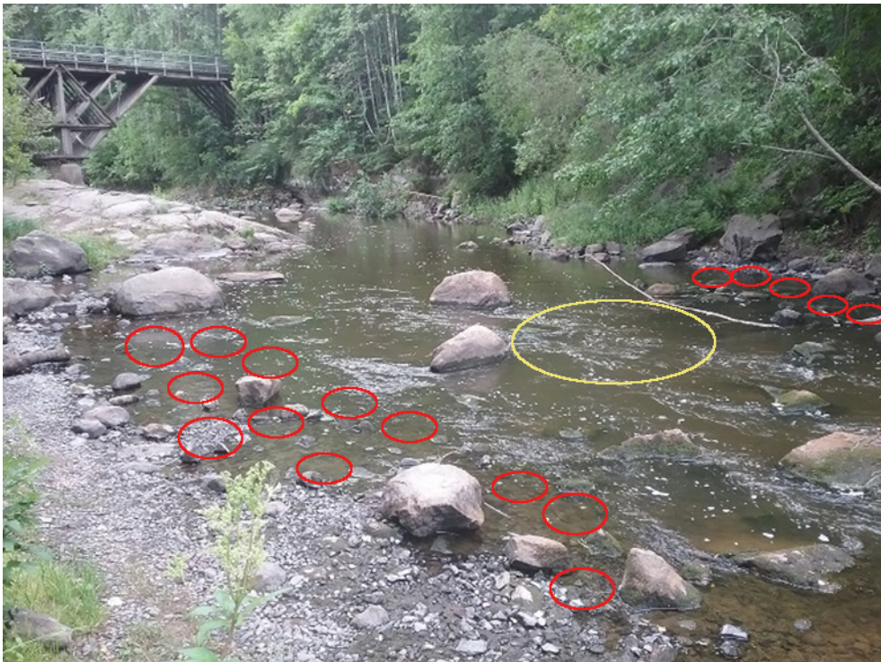
Kuva 58. Virran yleiskuva Siippoontien sillan alta kuvattuna kohti myllysiltaa. Koskikohdan alapuolella poिकासalueita tehdään molempien rantojen tuntumaan.
