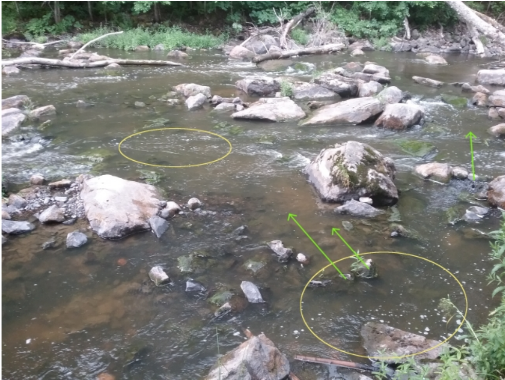
Kuva 66. Myllysillan ja vanhan patosillan keskiosaa vasemmalta rannalta kuvattuna. Isompia kiviä siirretään sivuun ennen soraistamista. Kuvan etualan soraikon ylävirran puolella olevaa kivikkoa tulee aukaista, jotta soraikolle saadaan parempi virtaus.
