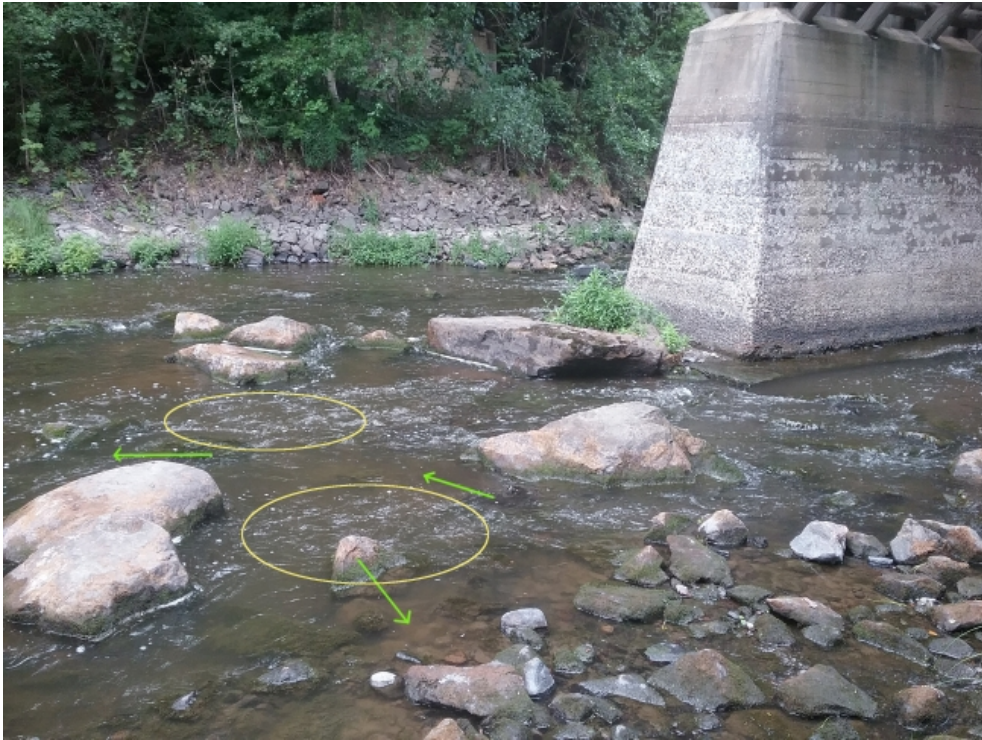
Kuva 64. Myllysilän heti alapuolelle tehdään kaksi pienempää kutusoraikkoa (noin 1,5–2 m 2 ). Isompia kiviä siirretään tarvittaessa sivuun ennen soraistamista.
