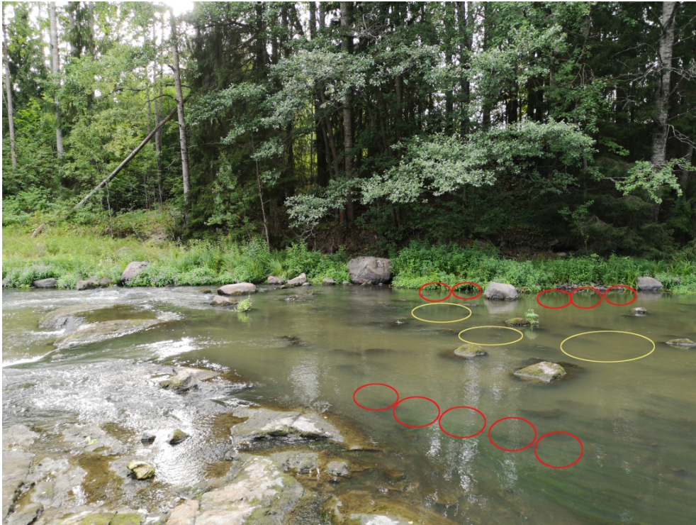
Kuva 39. Tampikosken kynnyksen yläpuolelle tehtävät soraikot (koko noin 1,5–2,5 m 2 ) tulee sijoittaa niin, että ne eivät ole paljaan kallion, vaan epätasaisen/kivisen pohjan päällä. Soraikkoja tulee tukea isommilla kivillä alavirran puolelta huuhtoutumisriskin pienentämiseksi. Kynnyksen yläpuolella olevia isoja kiviä siirretään tarvittaessa ohjaamaan paremmin virtausta soraikolle. Poikasalueita tehdään varsin oikean rannan puolelle, ja mahdollisesti myös vasemman rannan puolelle.
