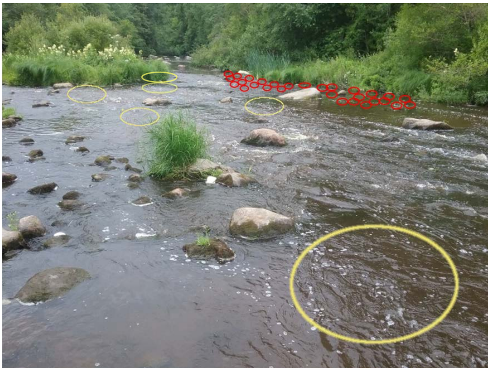
Kuva 88 Myllykosken alaosan rakennettavien soraikoiden paikkoja. Kuvan vasemmassa ylänurkassa näkyy aiemmin tekstissä mainittu heinäsaareke. Kuvassa ylimmäksi merkatun soraikon ympäristössä on vanhaa kunnostussoraa, jota tulee ensisijaisesti hyödyntää. Länsirannan alueelle tulee rakentaa poikalieuita.
