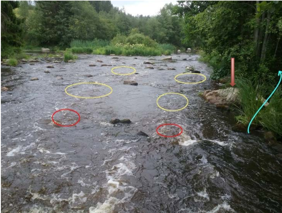
Kuva 85. Oikean rannan sivu-uoman kohdalle, päävirran puolelle rakennettavat soraikot (2–3 m 2 ). Tarvit- taessa lisätään isot kivet soraikkojen ylävirran puolelle hajottamaan suoraa kovaa virtausta.
