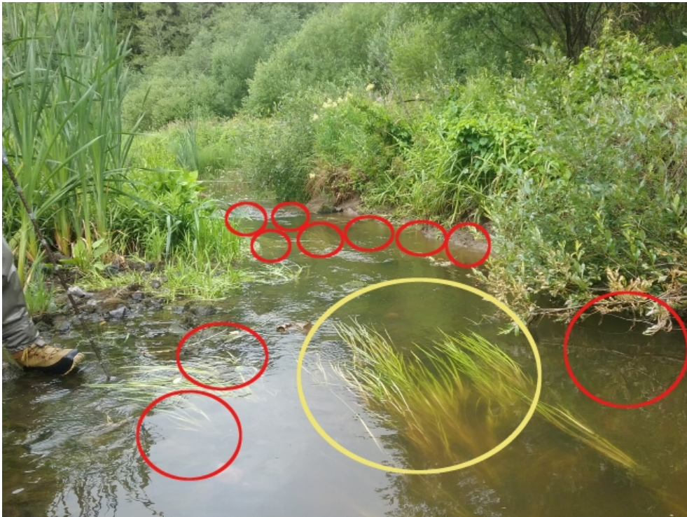
Kuva 46. Saarekkeen oikean rannan puoleinen pieni sivu-uoma yläpuolelta kuvattuna. Saarekkeen yläkärjen reunoille sijoitetaan kutusoraikko (noin 2 m 2 ) ja muuten sivu-uomaan tuodaan poikashabitaatiksi soveltuvaa kivimateriaalia. Soraikon laidoille voidaan tarvittaessa sijoittaa isompia kiviä kiihdyttämään virtausta.
