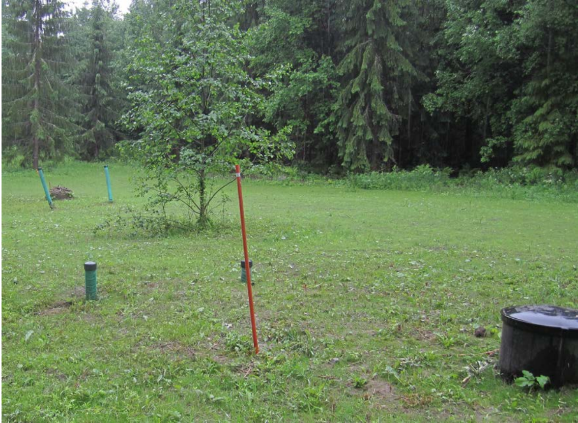
Kuva 2. Johtamalla käymäläjätevedet umpisäiliöön ja käsittelemällä pesuvedet käymäläjätevesistä erikseen, esimerkiksi maasuodatuskentässä (kuvassa), täytetään useimmiten myös hajajätevesilainsäädännön ankarammat, ohjeelliset puhdistusvaatimukset.
