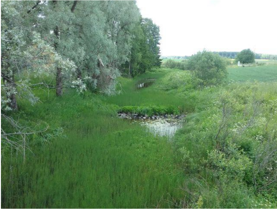
Kuva 64. Ohkolantien yläpuolinen pohjapato.
