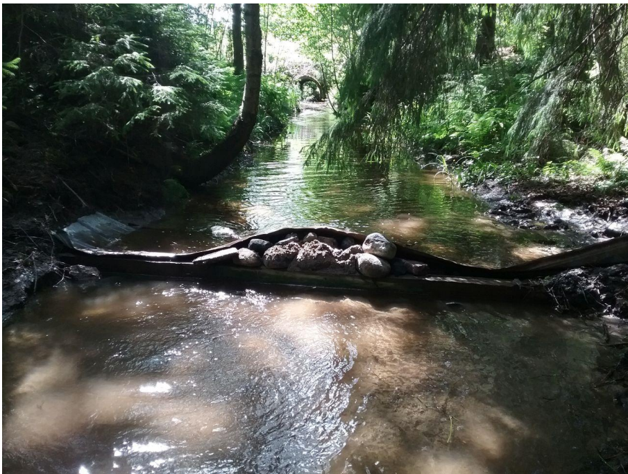
Kuva 8. Selänojantien alapuolella oleva rakennelma. Vesi pääsee virtaamaan osin peltilevyn ali kuvan vasemmassa reunassa.
