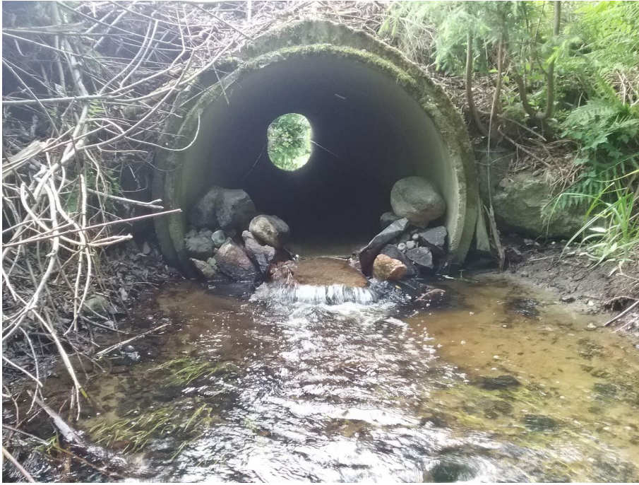
Kuva 7. Selänojantien alittava tierumpu. Kuvan keskeltä, peltilevyn alapuolelta on poistettu pari kiveä, jotta peltilevyn muodostama kynnys pienenesi.
