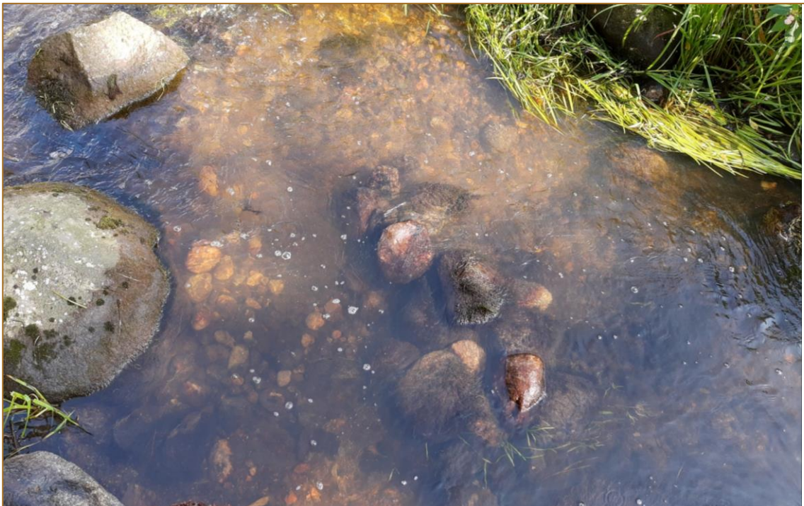
Kuva 3. Huollettu kaksiosainen soraikko, jossa virtausta on kiihdytetty lisäämällä virranohjauksiviestä rakennettu riutta, joka toimii samalla sorasta nousevien poikasten suojapaikkana.
