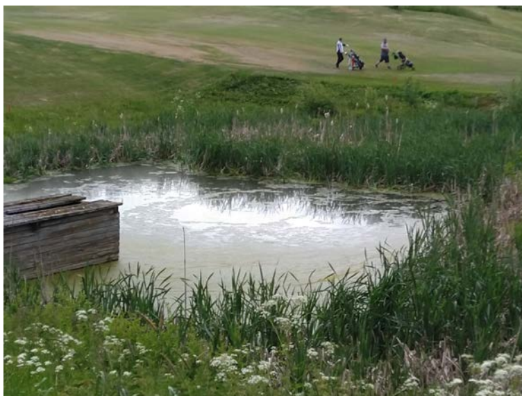
Kuva 4.48. Rinnekodin puhdistamolta käsitellyt jätevedet johdetaan kosteikon kautta Lakistonjokeen.
