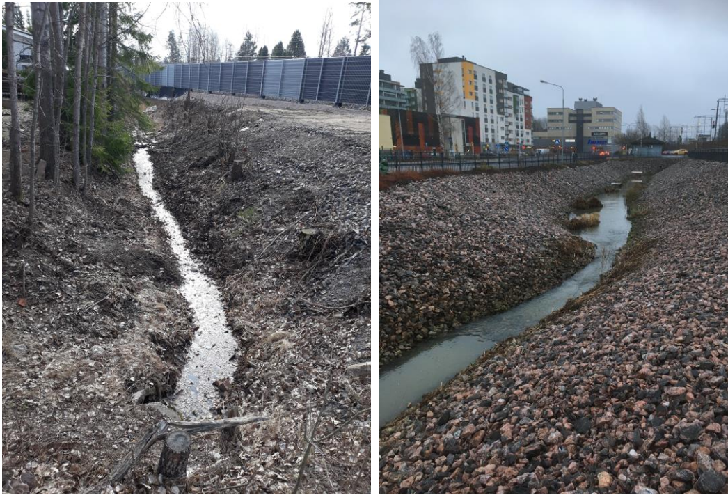
Kuva 4.10. Junaradan itäpuolen radanvarsioja (vas.) ja kivetty uoma liityntäpysäköintialueella, joka kokoaa radan itäpuolen hulevedet (oik.). Kuvat: Loutinoja kuntoon -hanke.
