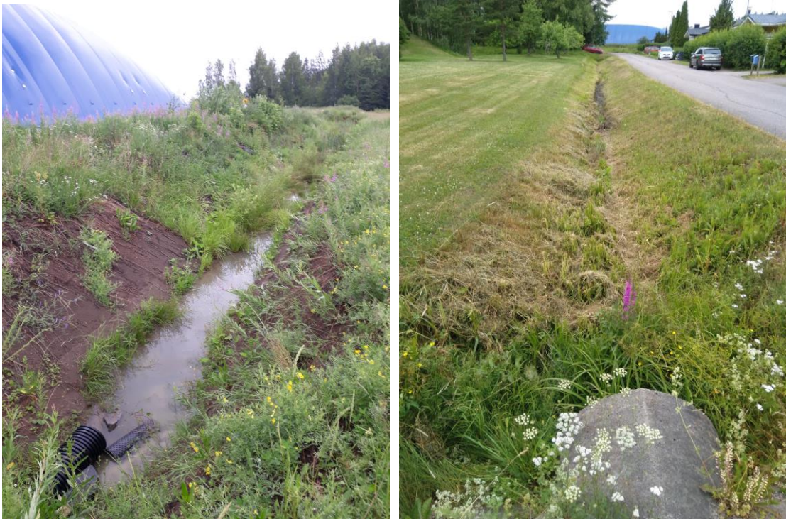
Kuva 4.4. Palloiluhallin viereen kaivettu hulevesioja (vas.) ja Lautakujan tienvarsioja (oik.). Kuvat: Loutinoja kuntoon -hanke
