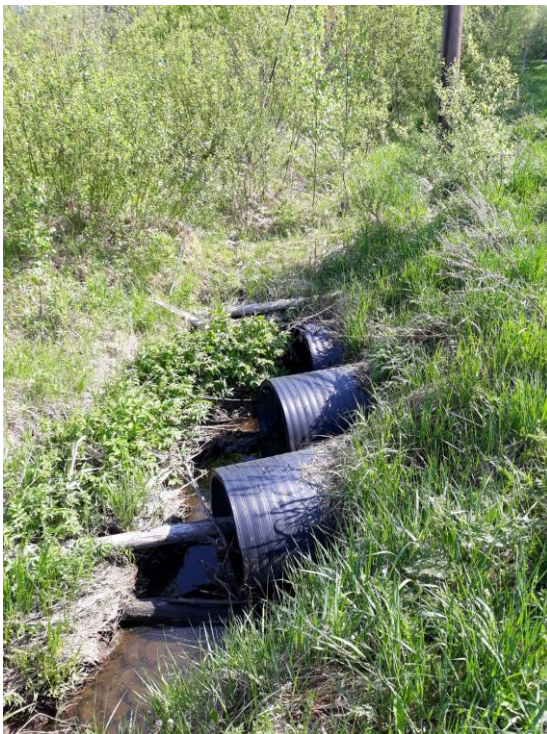
Kuva 6.2. Kävelytien alikulku Vähänummessa (vas.) ja rikkoontunut ojarumpu Pietolan alueella (oik.). Kuvat: Loutinoja kuntoon -hanke.
