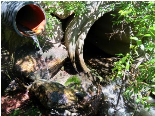
Kuva 4.9. Kuuselankadun tierummut muodostavat nousuesteen (vas.). Uoma virtaa hoidetun puistoalueen läpi kohti junaradan alitusta (oik). Kuvat: Loutinoja kuntoon -hanke.
