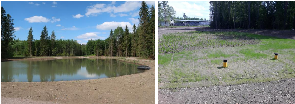
Kuva 4.3. Wärtsilän hulevesiallas (vas.) ja biosuodatuskenttä (oik.). Kuvat: Loutinoja kuntoon -hanke.
