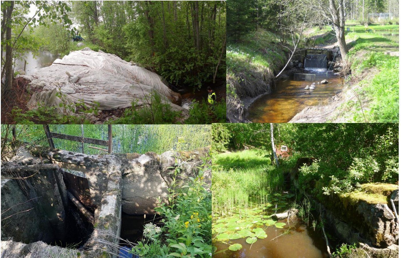
Kuva 3. Inventoinneissa vastaan tulleita erilaisia patoratkaisuja.
