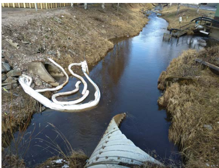
Kuva 3.11. Vantaanjoki katsottuna Teollisuuskadun sillalta ylävirtaan 14.4.2020. Versowood Oy Riihimäen yksikön tukkikentältä vedet johdetaan jokeen putkitettuna (kuvan oikea ylälaita) ja murskauskentältä Karoliinanojan kautta (vasen betoniputki). Ojansuussa oli öljypuomi, silla alueella oli todettu jo talvella jokeen tulevan öljyä.
